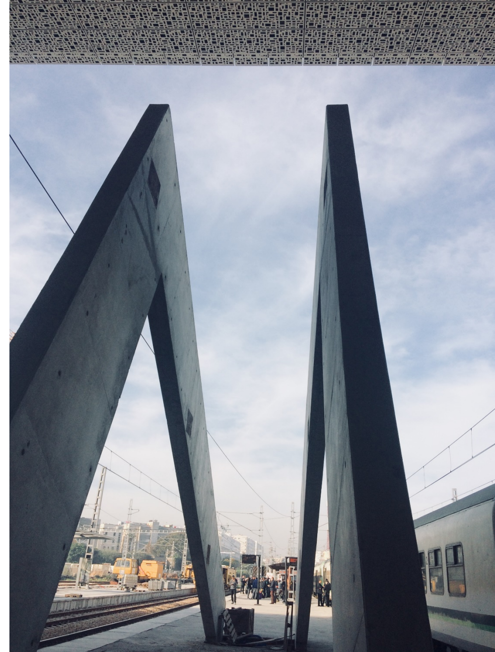
Lo stato del cantiere | Banchine 2018
