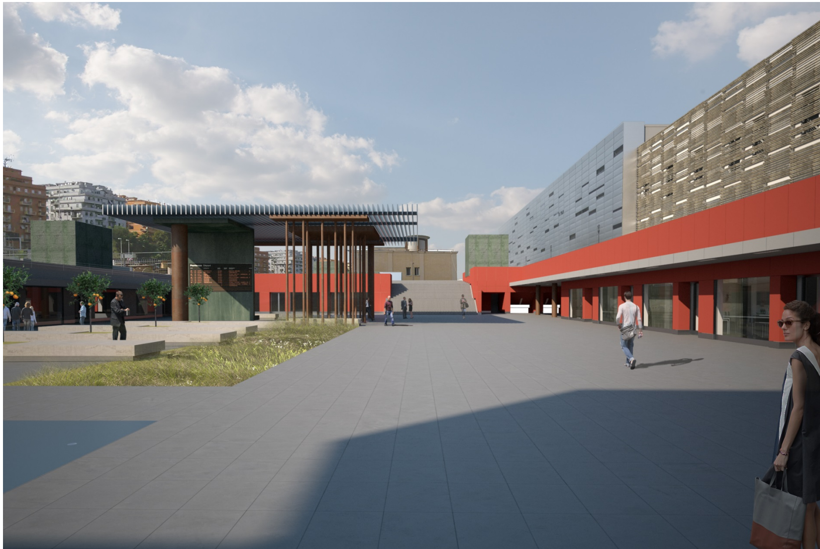
ROMA TIBURTINA | RICONFIGURAZIONE PIAZZA IPOGEA 2018 [IN COSTRUZIONE]
